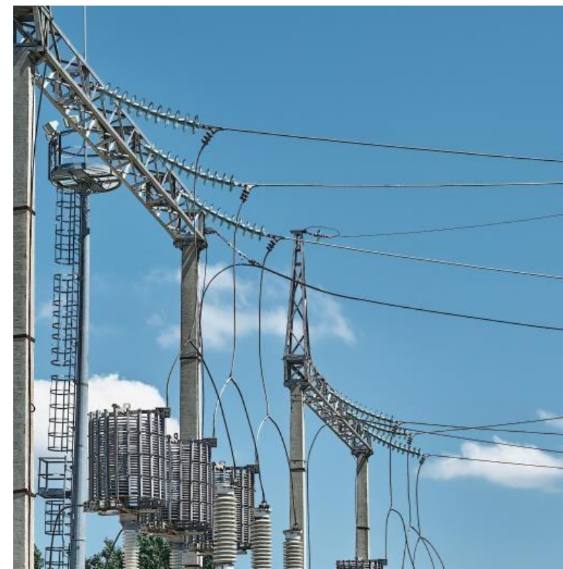
Budowa elektrociepłowni Turakurgan z linią napowietrzną 220-110 kV
