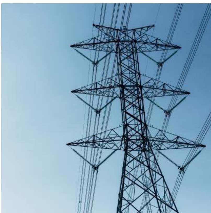
Budowa dwutorowej linii napowietrznej 220 kV od Elektrociepłowni Syrdaria do stacji Pechnaya i stacji Hutniczej
