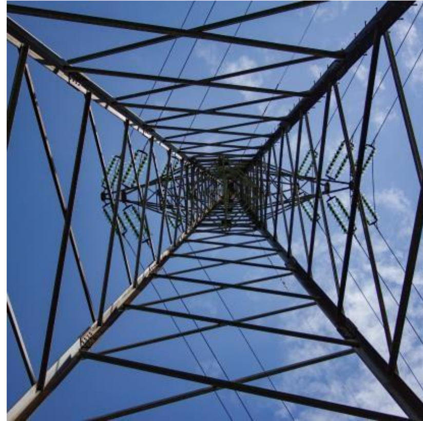
Budowa dwutorowej linii napowietrznej 110 kV w ramach projektu „Przyspieszenie budowy obiektów farm wiatrowych Tashkent Cotton Textile LLC”
